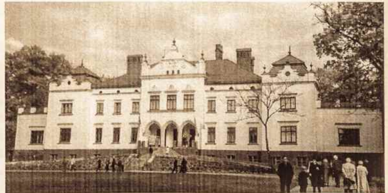
Po restauracijos šviečia Rokiškio dvaras.
