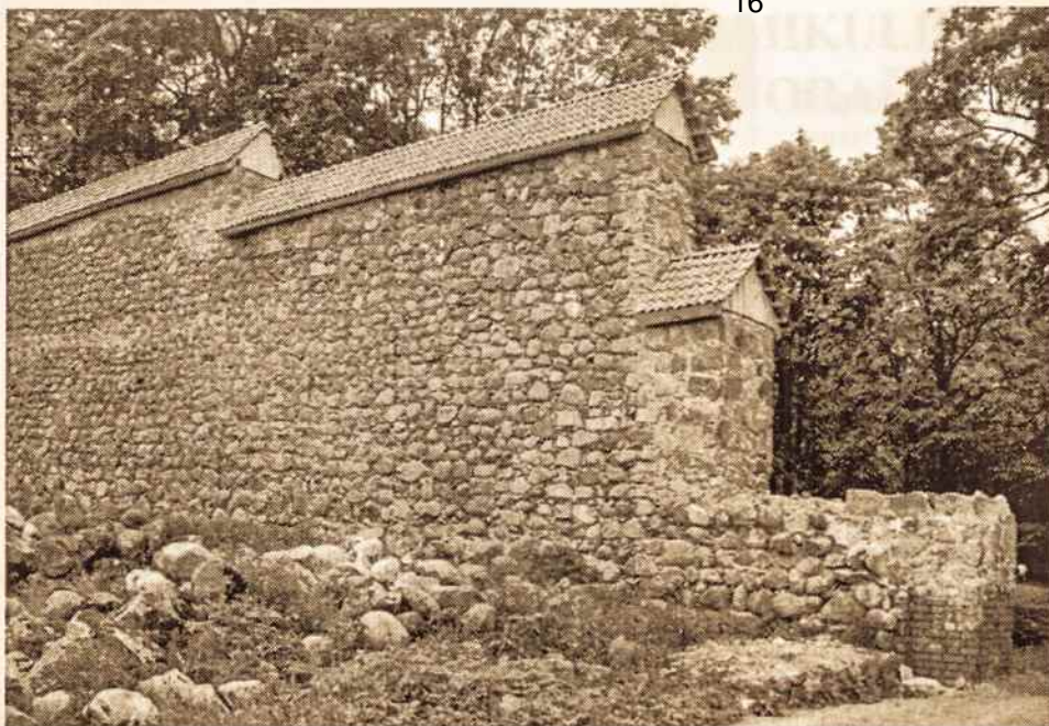
Uždengti gynybines sienas apsauginiais čerpių stogeliais pasiūlė S.Mikulionis
