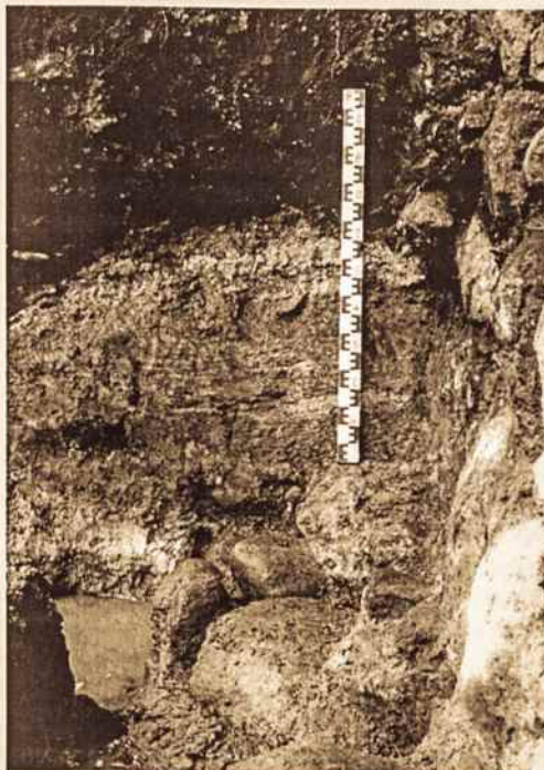
Pilies rytinės sienos pamato išplatėjimas vadinamas bankete
