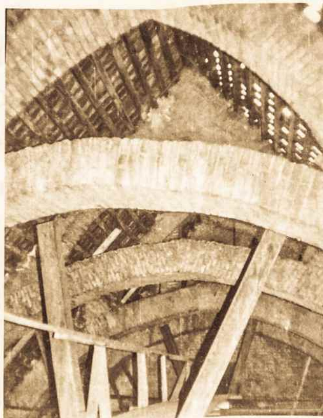
Vilniaus šv. Onos bažnyčios mūrinės gegnės XVIII a konstrukcija
