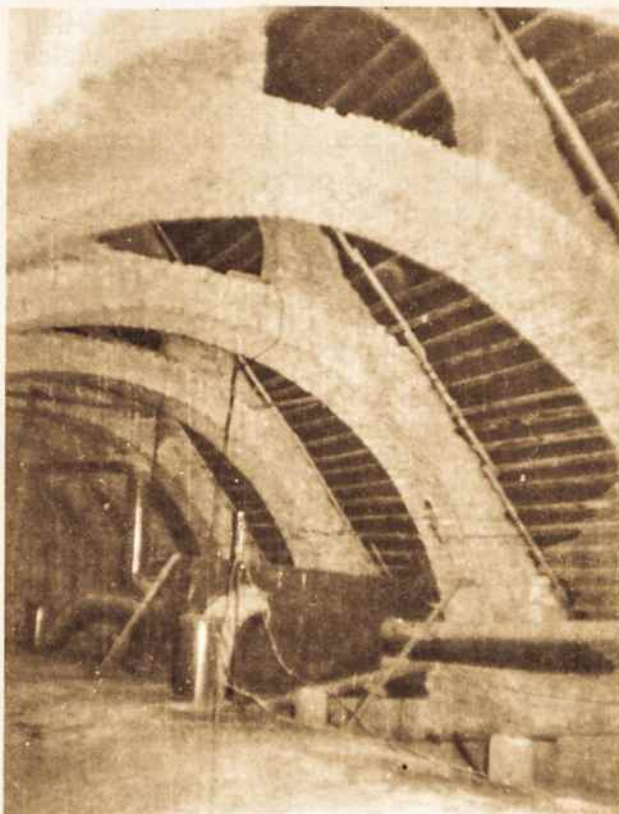
Vilniaus šv. Teresės b-čios mūrinių gegnių stogas
