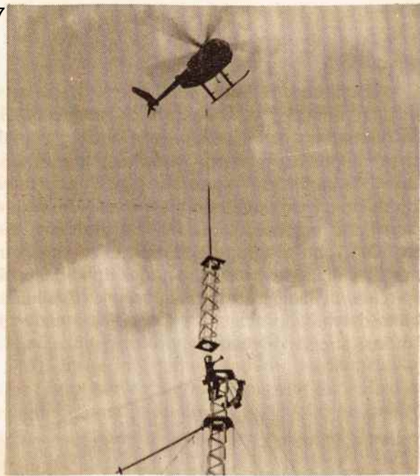
Pav. 8 - Malūnsparnis atneša detalę
