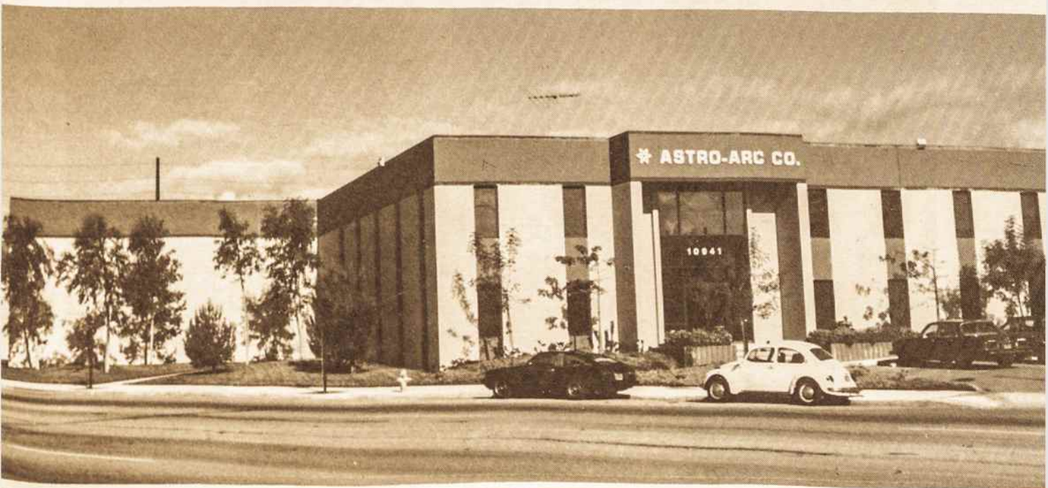
ASTRO-ARC bendrovės pastatai
