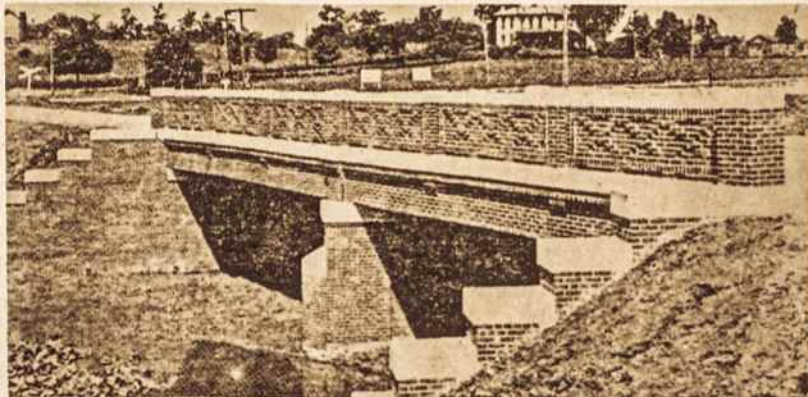
Vielomis sustiprintų plytų tiltas, Sugar Creek, Ohio
