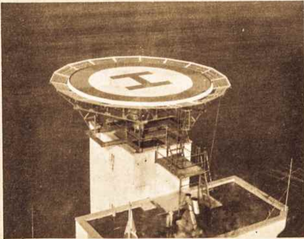
Pav. 5. Helikopterio platforma įrengta ant seniau pastatyto (1956 m.) švyturio White Island.
