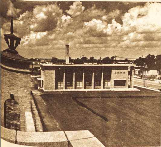
Marijonų vienuolyno bokštas ir „Drungo“ pastatų rytinis fasadas.
