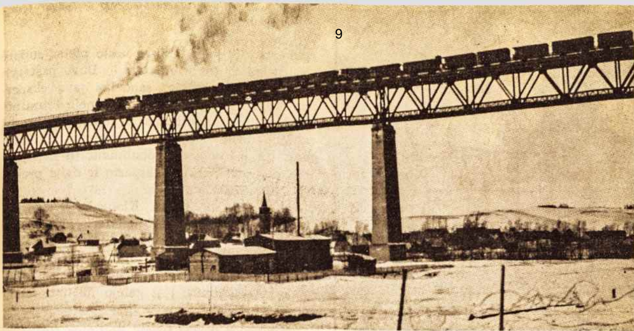
Lyduvėnų plieninis geležinkelio tiltas
