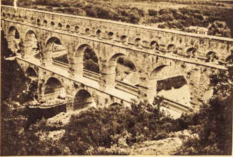
Garsusis "Pont du Gard" prie Nimes, pietų Prancūzijoje. Pirmajame aukšte išvestas kelias, antrajame ir trečiajame — vandens kanalai. Tai vienas geriausiai išsilaikiusių Romos tiltų statybos pavyzdžių.
