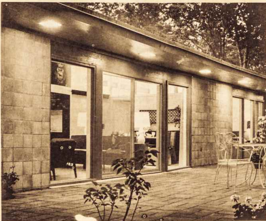
N a m ū s t a t y b a. Veranda išklota 2 colių blokais. Sienos — 8 colių sausai dėti blokai (Form — Block), surišti armatūra ir pripildyti izoliacinio skiedinio.
