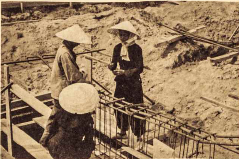
Kolonos pado armatūros dėjimas.
