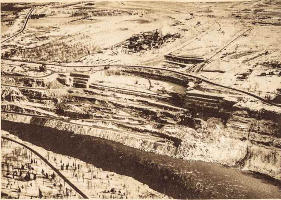
Lewiston jėgainės statybos vieta 1958-1959 metų žiemą [foto PASNY]
