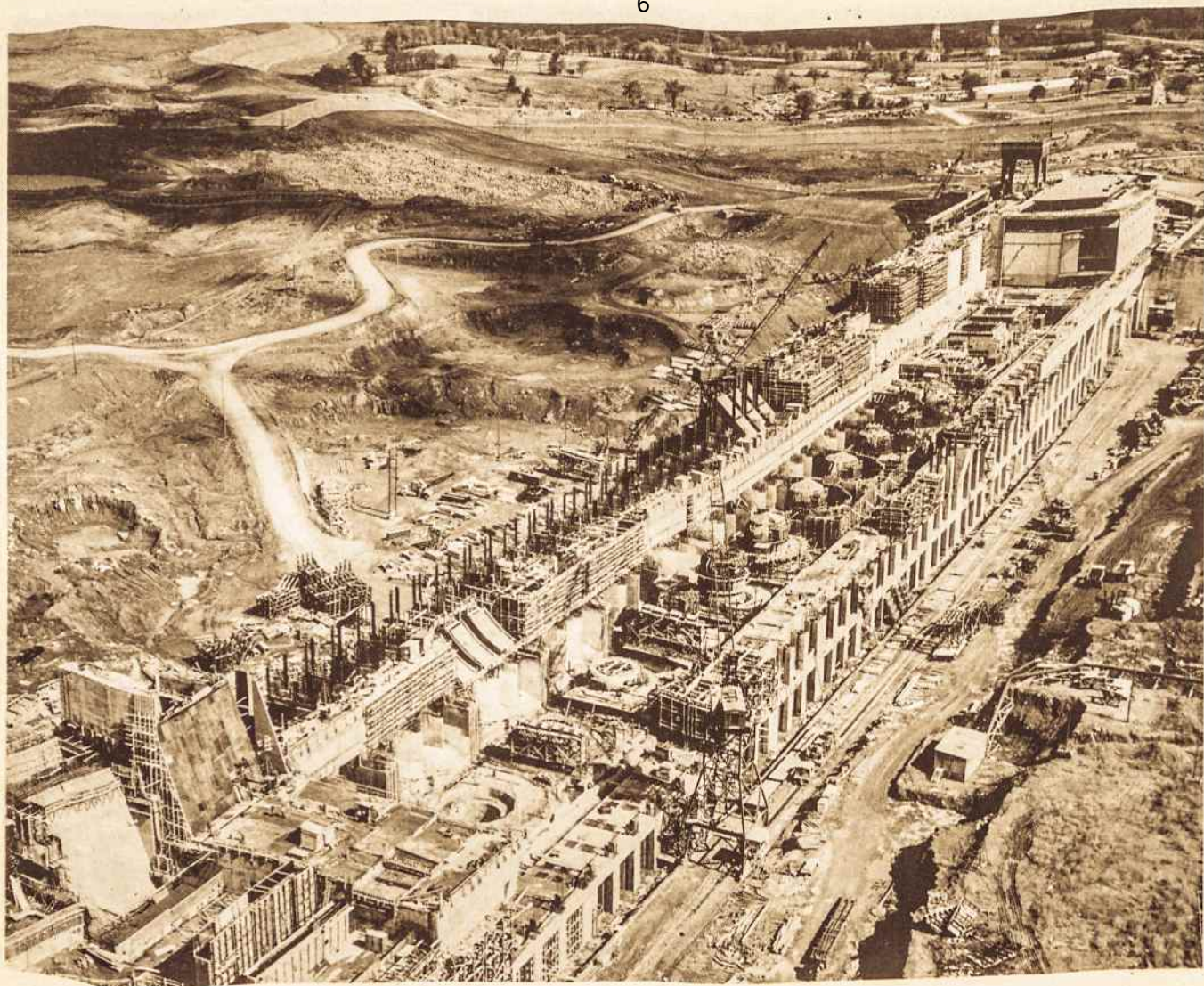
Pav. 5. Kanados pusės jėginės statybos vaizdas 1957 m. rugsėjo mėnesį (Foto HEPCO).
