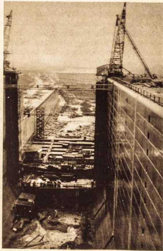
Eisenhower stužas prie Massena, N.Y. Žemutinių vartų įrengimas su 110 pėdų aukščio sienomis.
