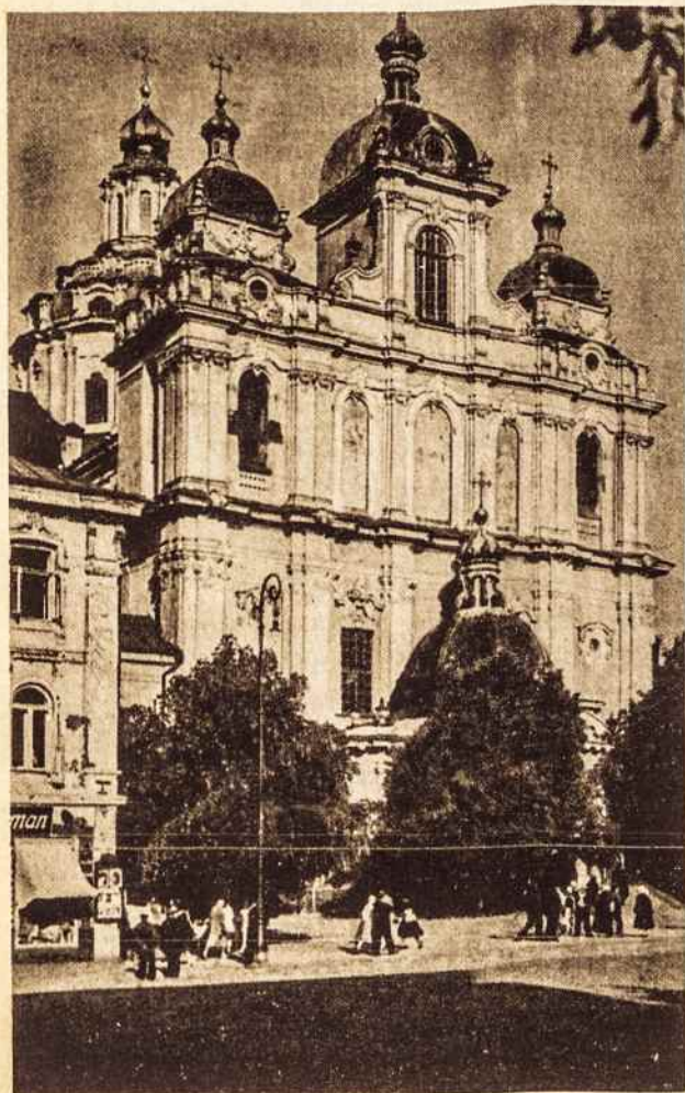
Šv. Kazimiero bažnyčios vaizdas apie 1930 m. Arch. Čaginas, 1867 m. restauruodamas bažnyčią, karūną nuėmė ir uždėjo rusiškus cibulius, o fasadui suteikė rokoko žymių. 1925 m. lenkai restauruodami kryžius pakeitė, bet karūnos negrąžino.
