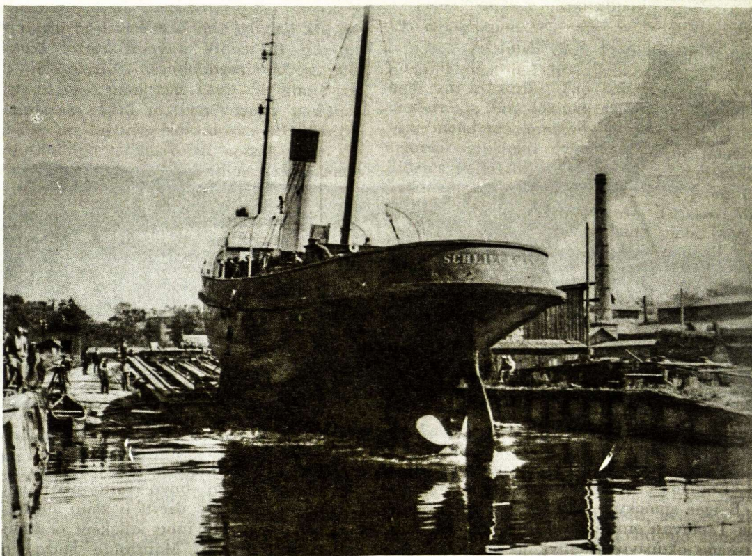
Locų laivas SCHLIECKMANN — ŠARŪNAS Klaipėdos uosto dirbtuvėse 1929 m. po remonto nuleidžiamas į vandenį.
